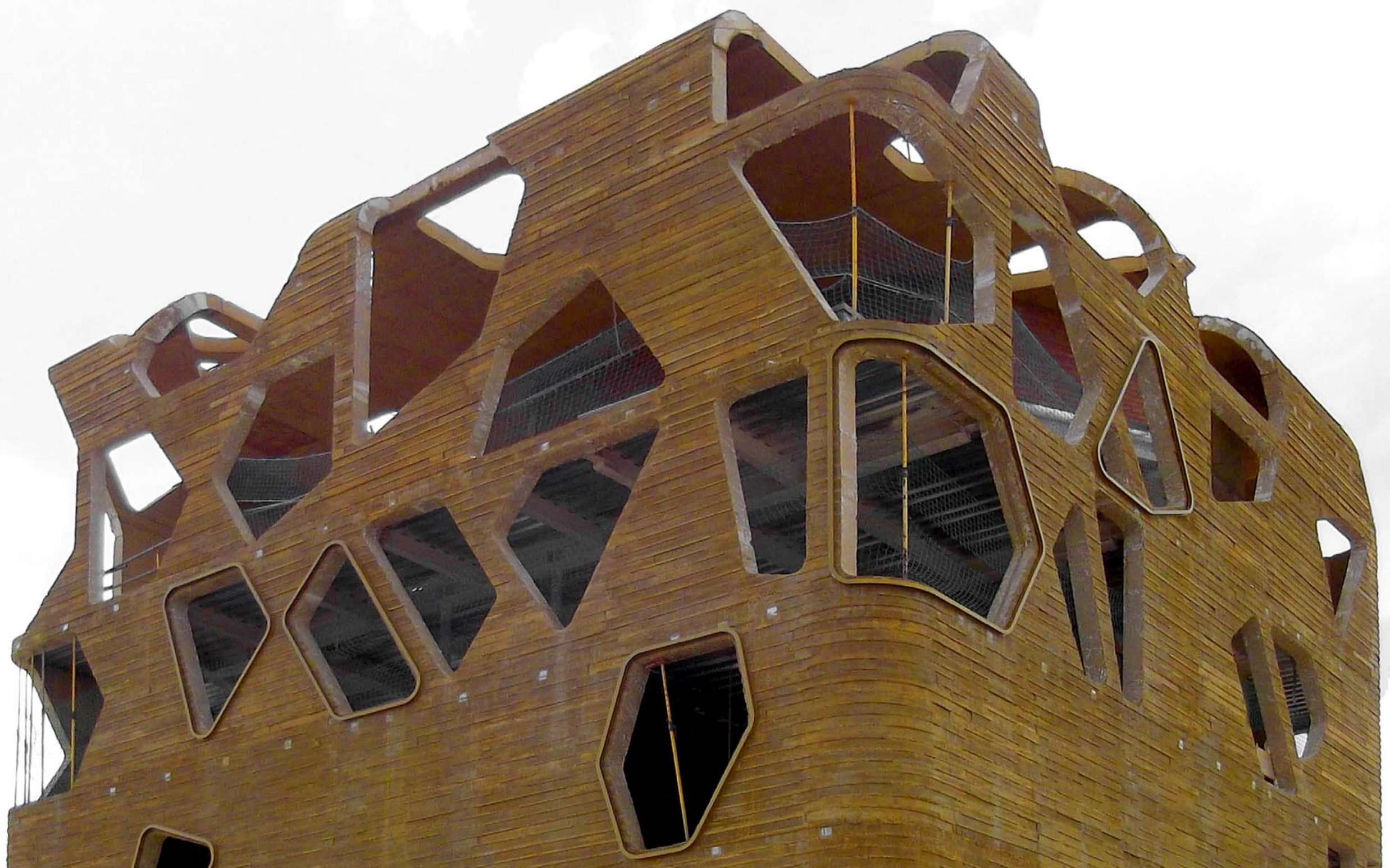
Palacio de Congresos "Vegas Altas". Villanueva de la Serena (Badajoz), 2008. Pancorbo Arquitectos + DVCH Foto: Pancorbo Arquitectos
