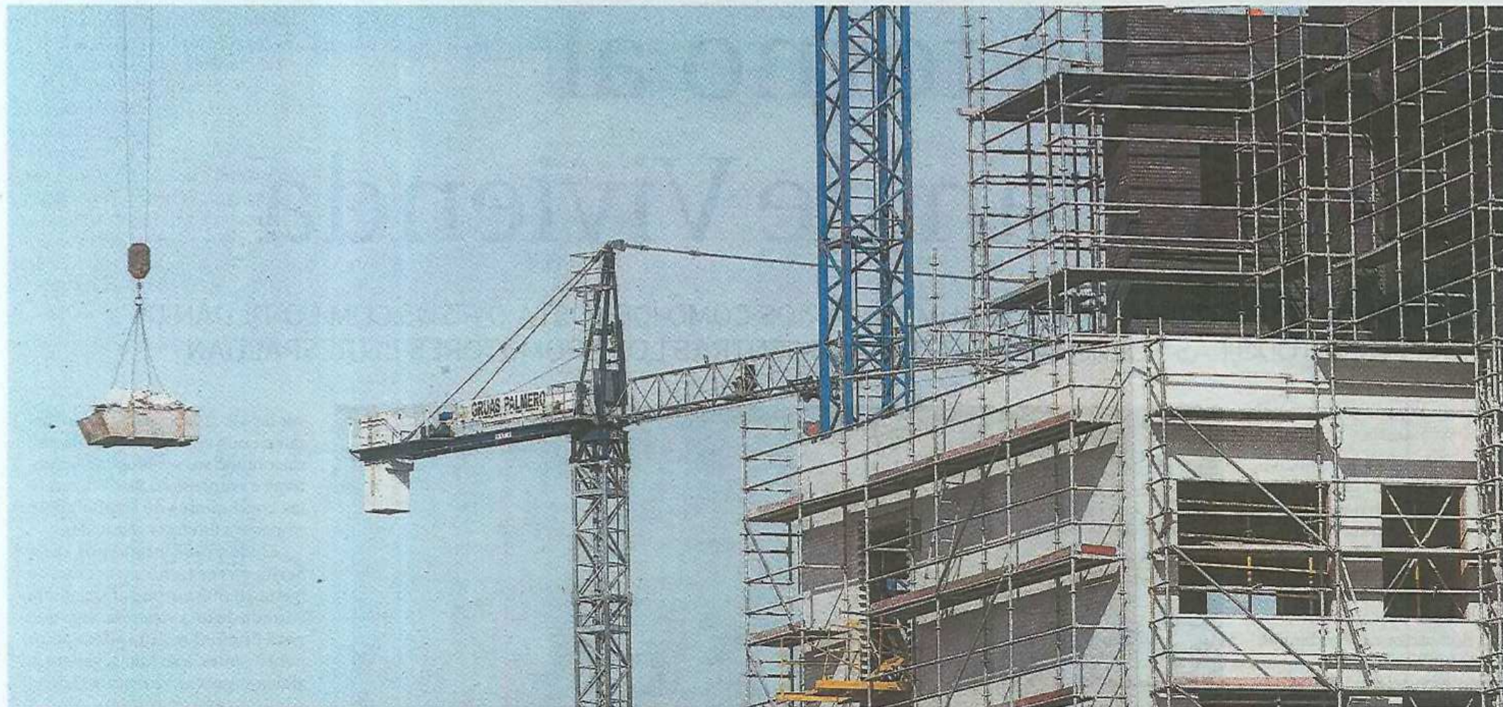
MOVIMIENTO. EN LOS ÚLTIMOS MESES ES MÁS HABITUAL VER GRÚAS EN FUNCIONAMIENTO EN LAS ZONAS DE EXPANSIÓN DE LA CAPITAL. / LLA.
