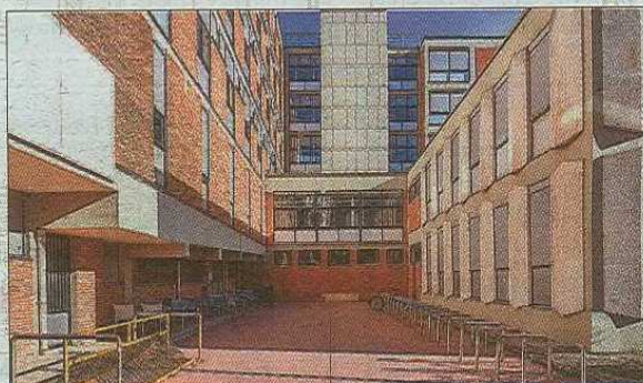
Todas las aulas, despachos y corredores cuentan con luz natural.
