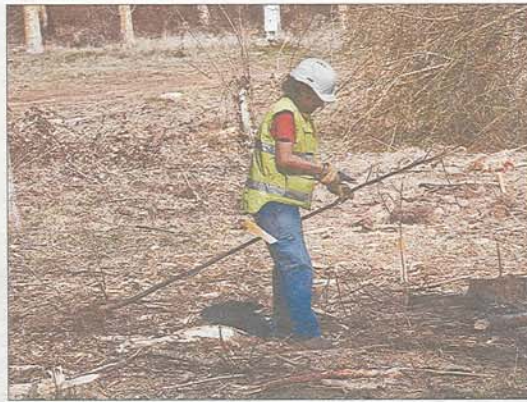
Los trabajos se están desarrollando a buen ritmo.
