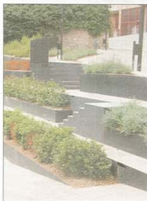
Segunda fase del ARCH en Burgos.
